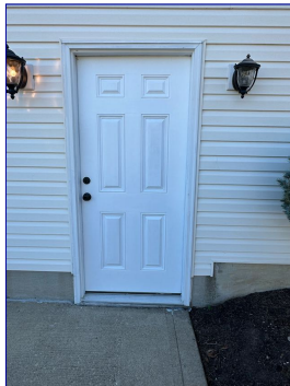
Garage man door
